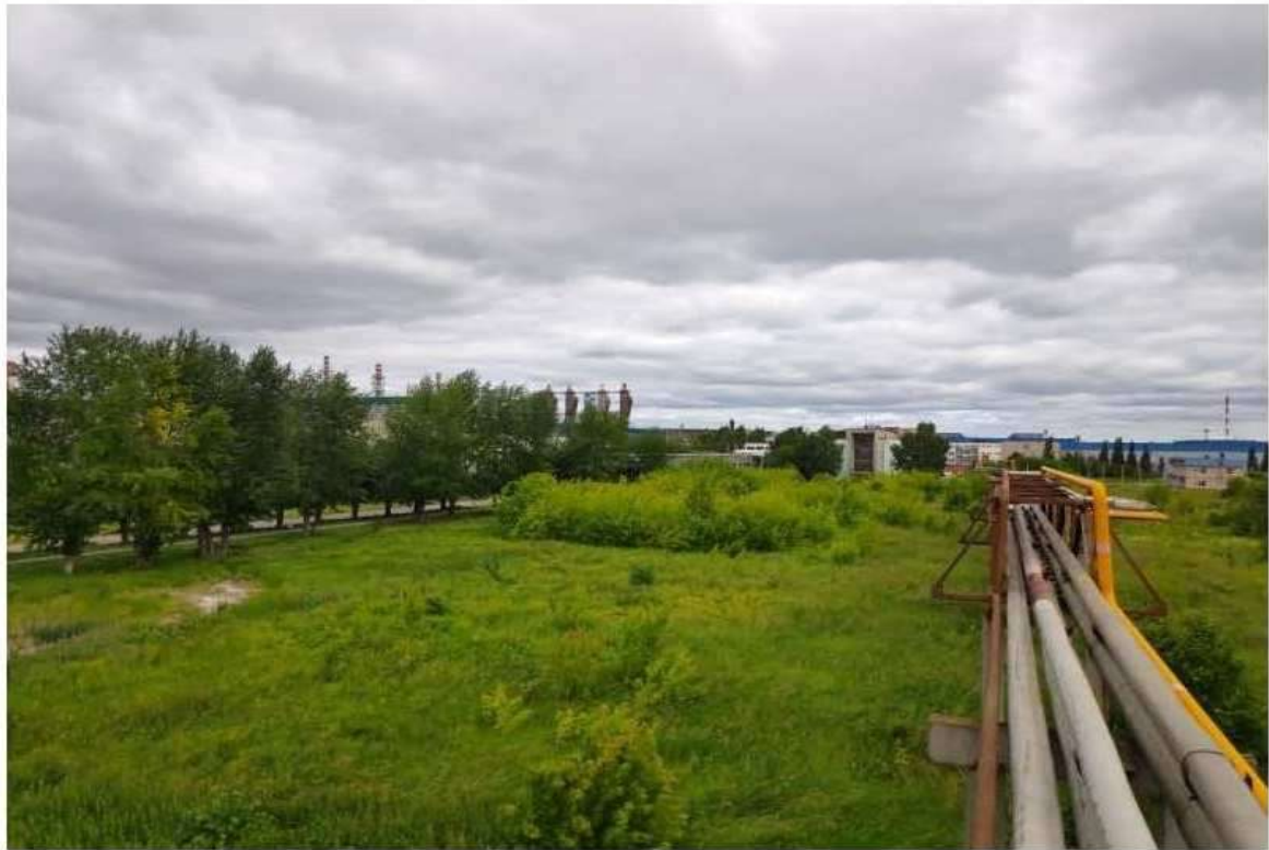
Площадки строительства очистных сооружений.
