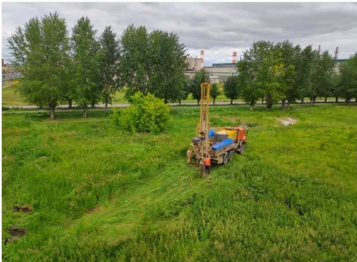
Бурение скважины на площадке строительства
